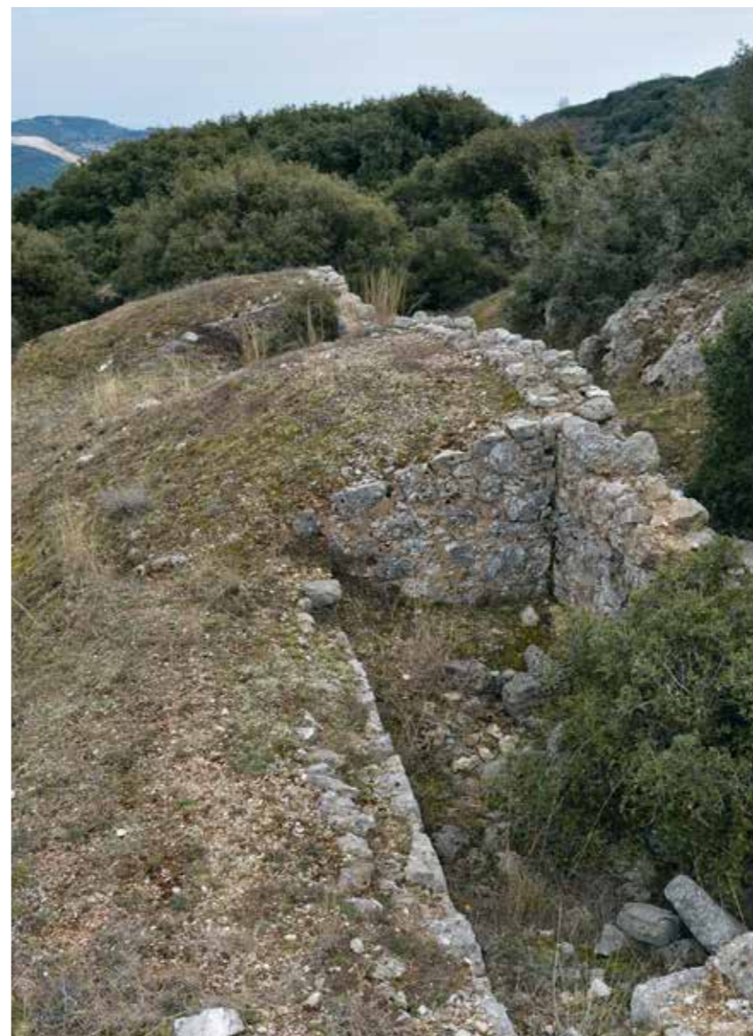
8. Π.Ε. Καβάλας. Θέση 5. Άποψη του προμαχώνα/ χαρακώματος: ενισχυμένες θέσεις μάχης
